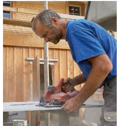
La nouvelle étable est terminée mais Sepp travaille chaque minute qu'il a de libre à la construction du nouveau chalet.
