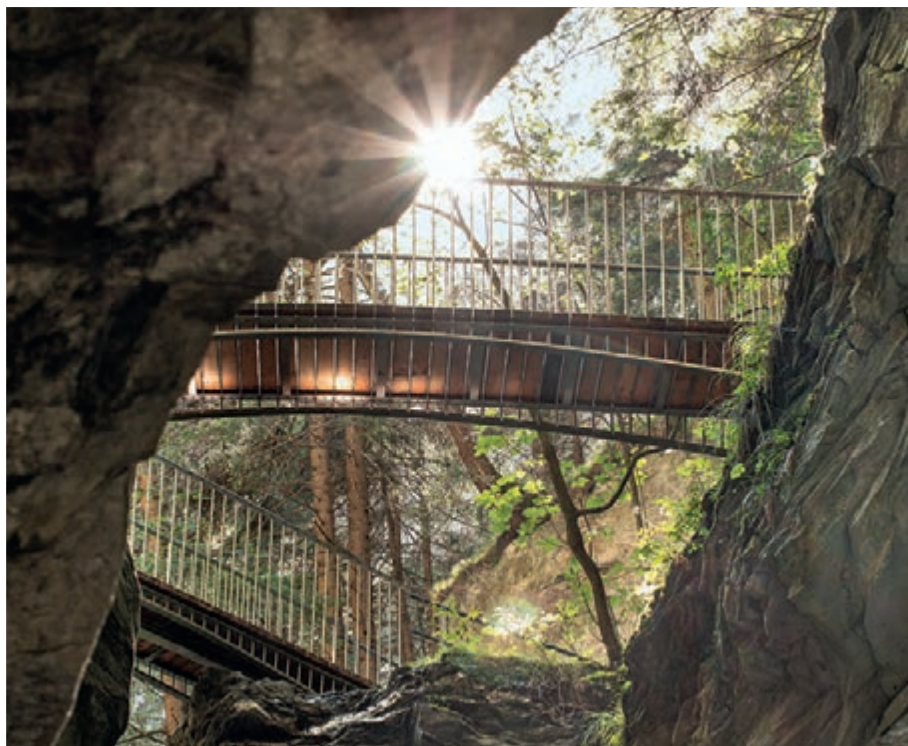
Les ponts jumeaux dans la gorge de la Viamala permettent de diriger le flot des visiteurs sur diverses passerelles.
