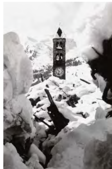
L'église d'Airolo après l'avalanche de la Vallascia le 12 février 1951.
