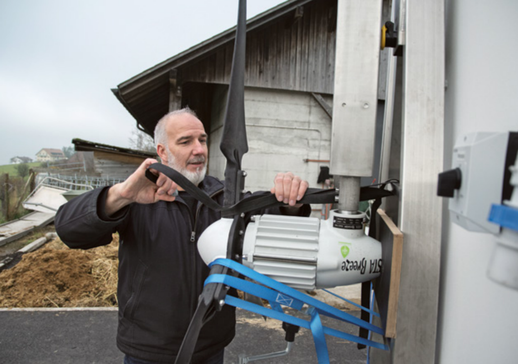
En un tournemain la centrale électrique mobile a été installée.
